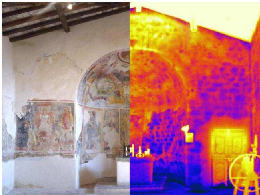
Esempio di analisi del degrado della muratura causato dall'umidità.
