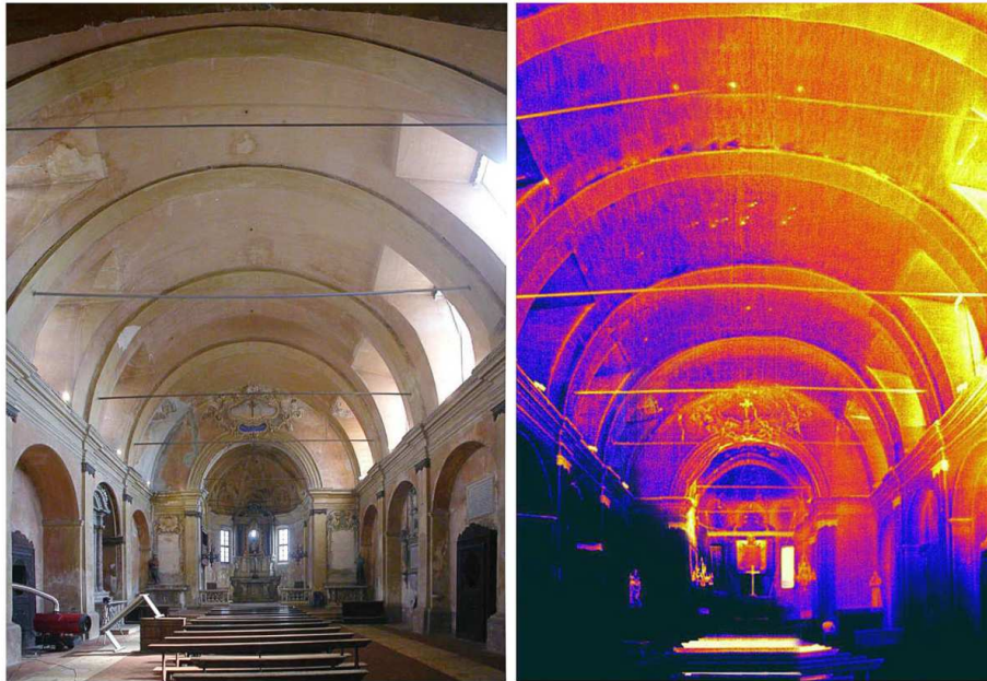
CHIESA DELLA DISCIPLINA: RILEVO TERMOGRAFICO DELLA NAVATA E DEL PRESBITERIO TINT 13,4°C; URINT 43,6% TEST 11,8°C; UREST 19,0% RANGE 13,5°C – 17,5°C
